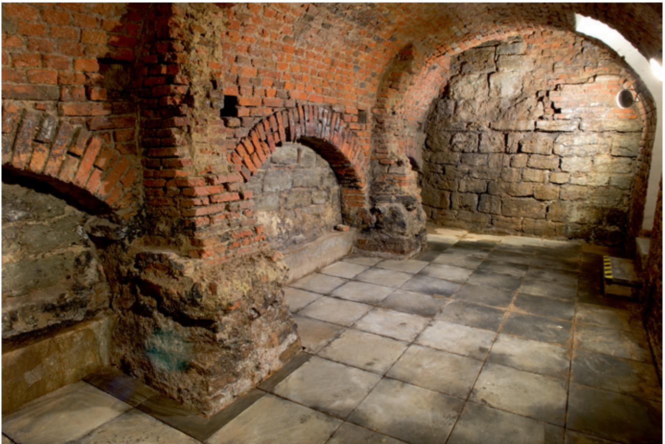
Een grote beerput onder een huis aan de Grote Markt van Dendermonde. Na de opgraving van de zestiende-eeuwse vulling (zie Beeckman en Van Hecke, in druk) bracht de huidige eigenaar een vloer aan en werd rechts in de wand een toegang met trap gemaakt. © Stad Dendermonde
